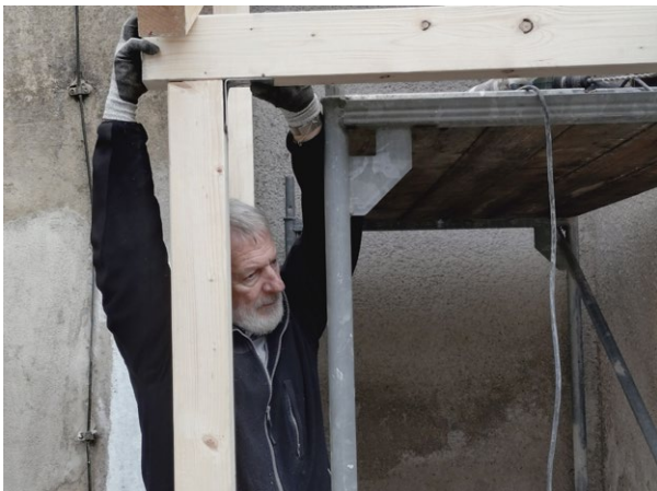
Volker Buß stemmt die Balken in die richtige Position
