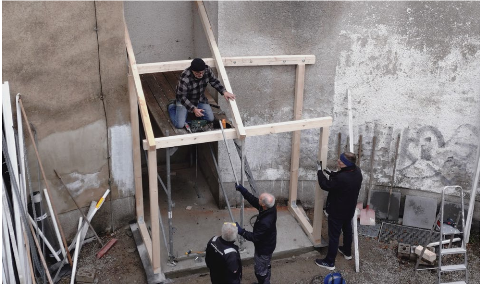
Peter, Volker, Günter und Axel beim Bau der Gerätehütte
