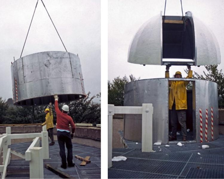
**Abb. 3a (links): Das Unterteil der Westkuppel schwebt herab, gehalten von Volker Buß (links) und Bernd Morasch. – Abb. 3b: Volker Buß setzt die hölzerne Kuppel auf das Unterteil.**
